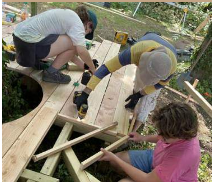
Chantier participatif d'écoconstruction. Photo : Association SEED, 2025.
